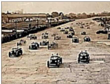
Dålig beläggning på Brooklands-banan.
