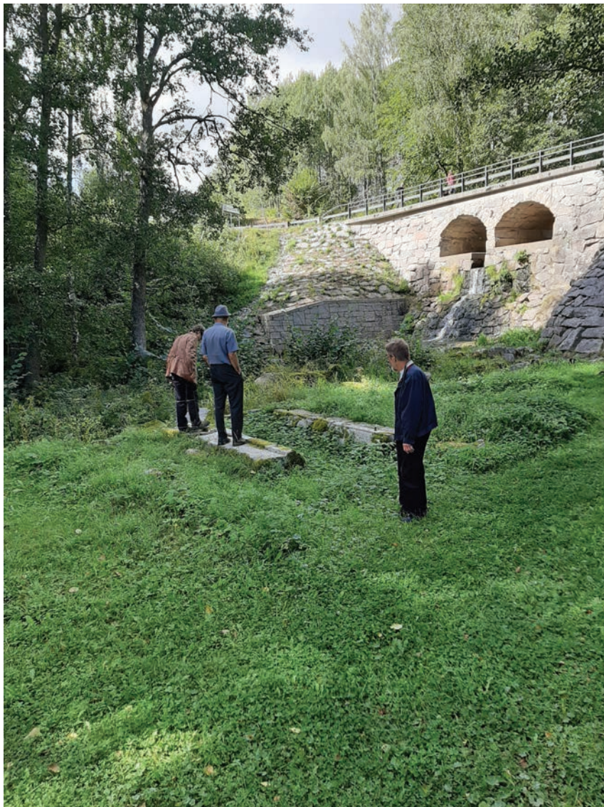
Axelfundament till kvarnhjul nedanför Ytterkvarns bro
